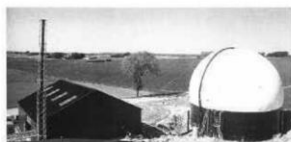
Vieux digesteur à cloche souple)
